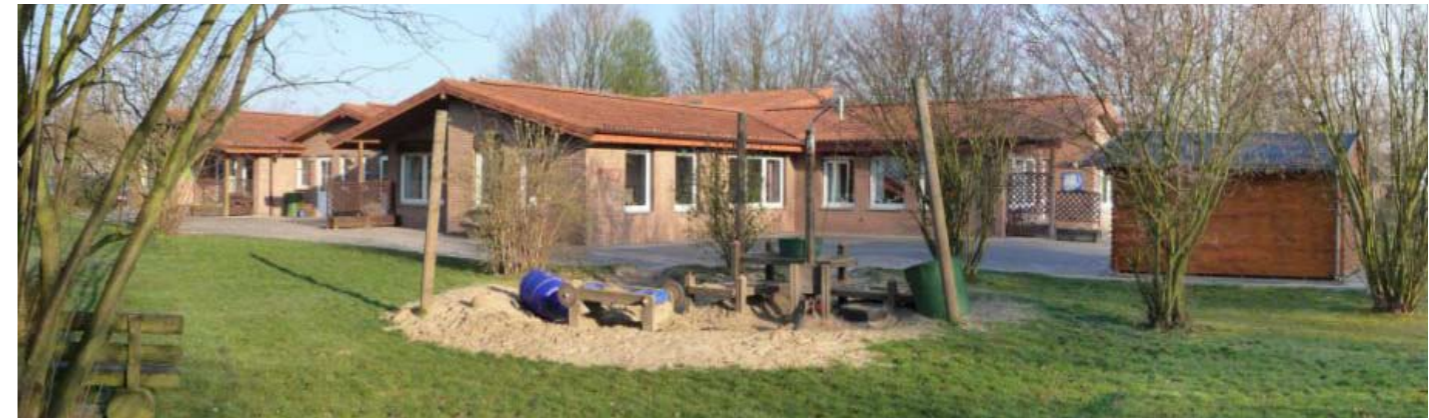
Seit 1991 Heimat der „Pusteblume“: Der Neubau am Twilen in Kachtenhausen.
